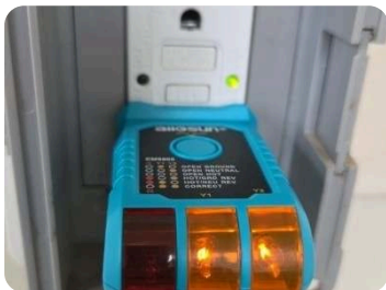
외부 GFCI 콘센트 테스트
