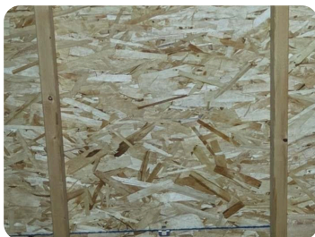
지붕 덮개판, 건조한 상태
